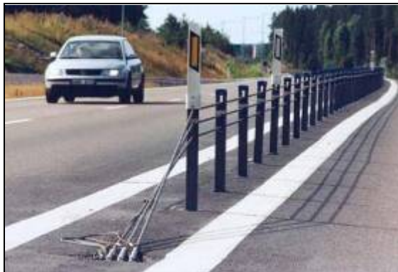
Figure 4 : Glissière à câbles haute tension – exemple suédois (8)
