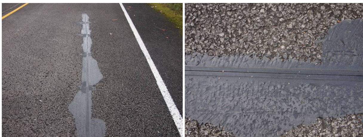
Figure 7 – Insertion dans le revêtement
