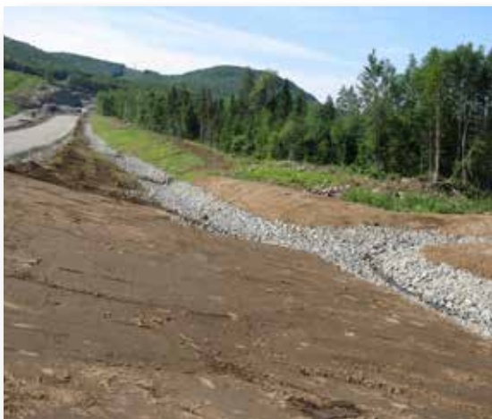
Fig.12 Fossé aménagé dans un secteur de route en remblais
