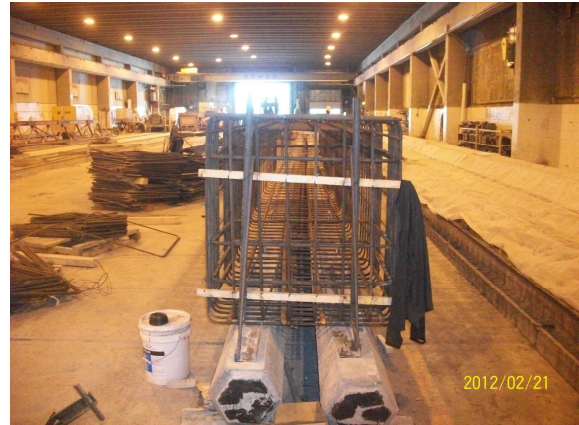
Photo 2: Non Prestressed Longitudinal Reinforcing Steel
