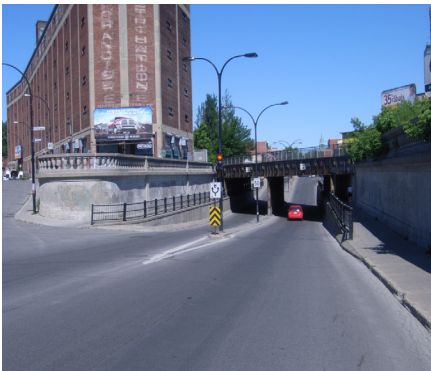
Figure 10: Secteur du boulevard Saint-Laurent sous le viaduc ferroviaire
