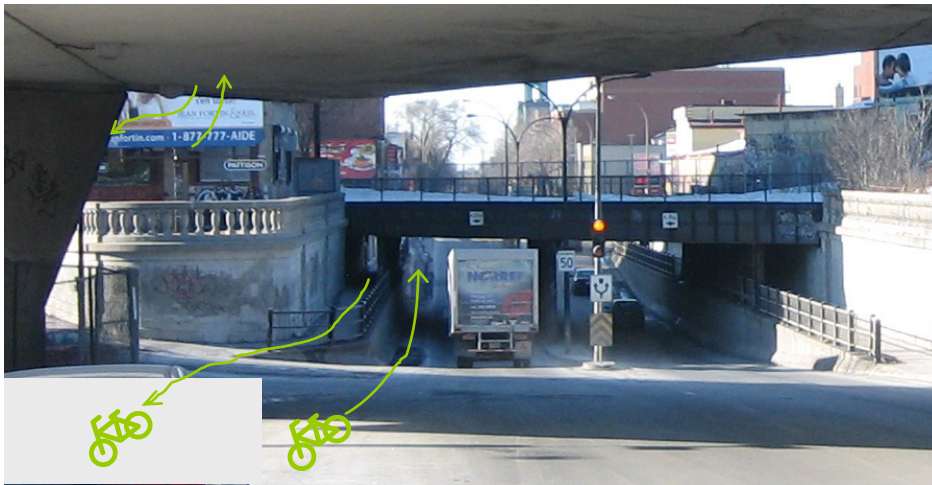
Figure 12 Option 1 : bande cyclable en direction Nord dans la chaussée du côté Ouest et bande cyclable en direction Sud dans le trottoir du côté Ouest
