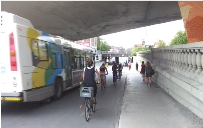
Figure 3: Trottoir sous le viaduc ferroviaire
