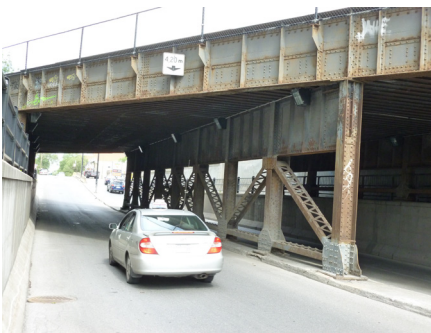
Figure 11: chaussées sous le viaduc ferroviaire
