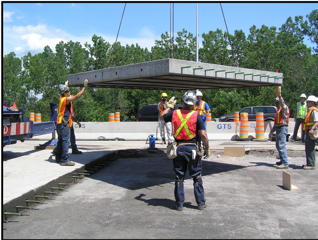
Figure 7 – Pose de dalles préfabriquées en construction (2008)
