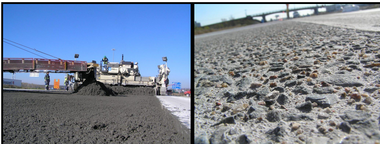
Figure 8 – Construction d'une dalle en béton en 2 couches et dénudage chimique (2008)
