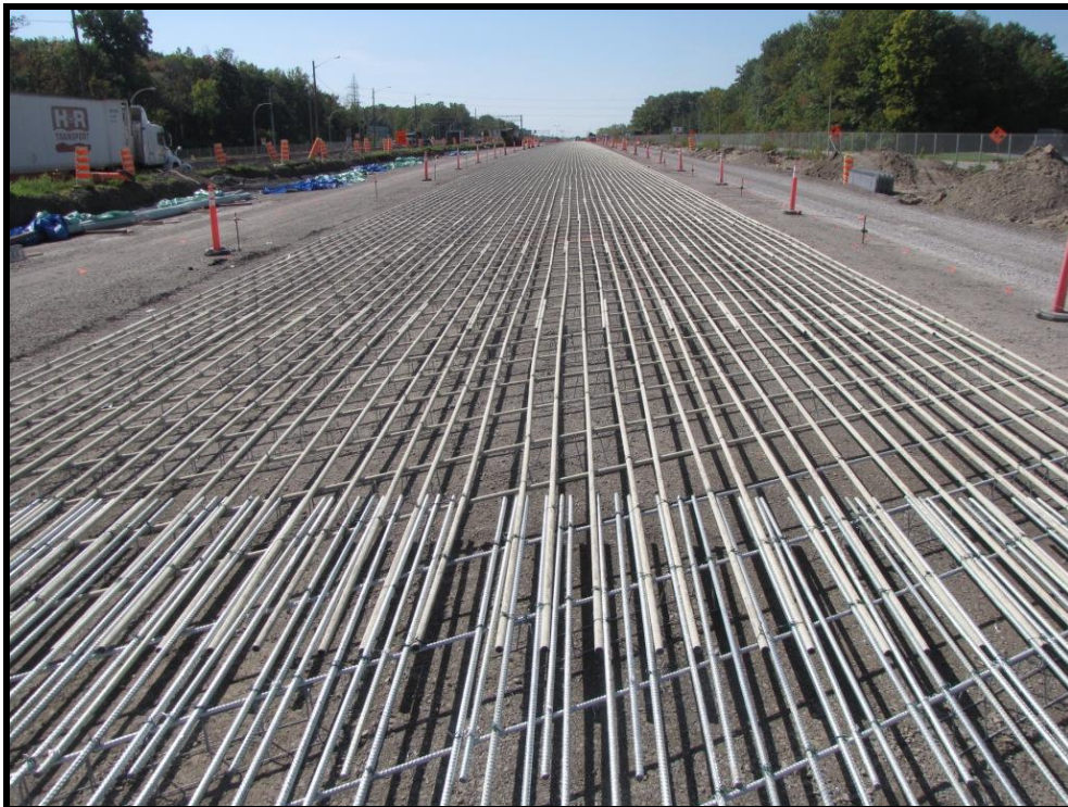
Figure 4 – Section de 300 m en armature en polymère renforcé de fibre de verre (2013)
