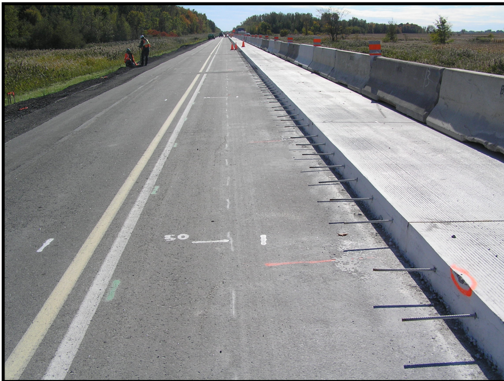
Figure 6 – Recouvrement en béton d’une chaussée souple (2010)
