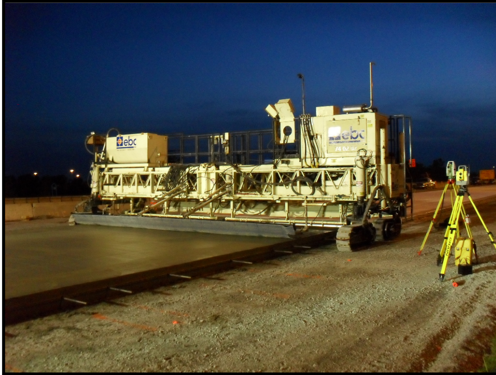
Figure 5 – Pavage d’une dalle en béton avec une station totale robotisée (2010)
