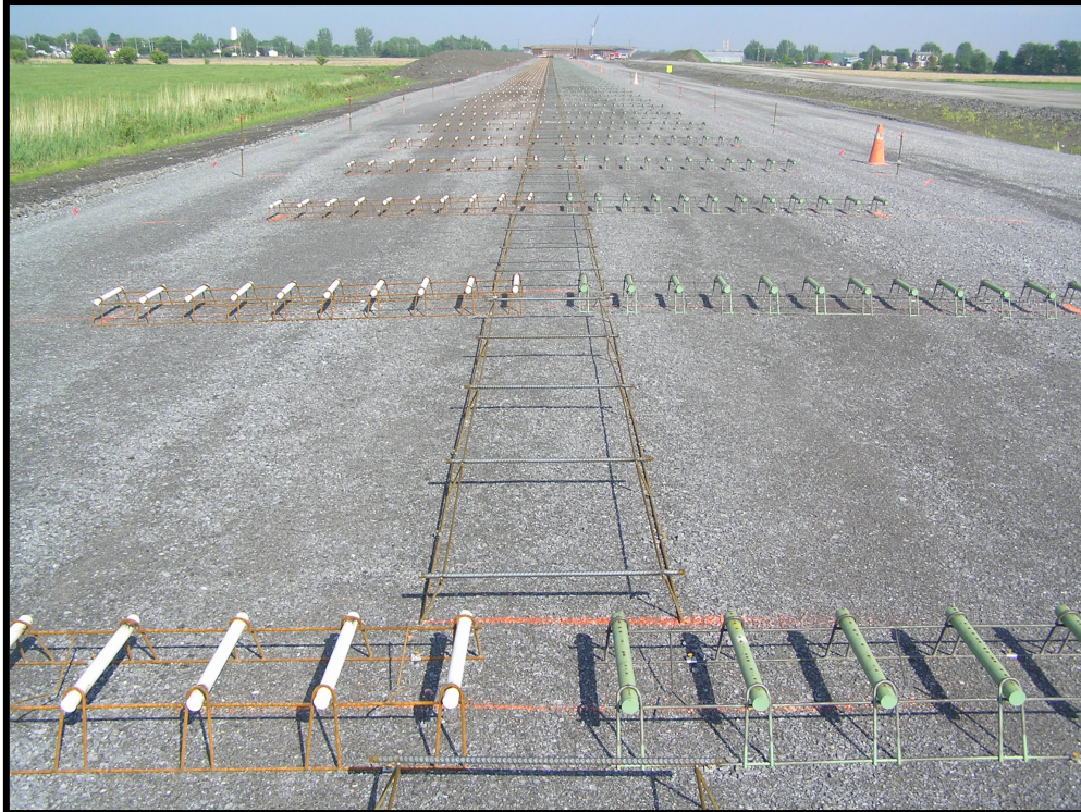
Figure 3 – Paniers à goujons en acier (vert) et en polymère renforcé de fibre de verre (blanc)
