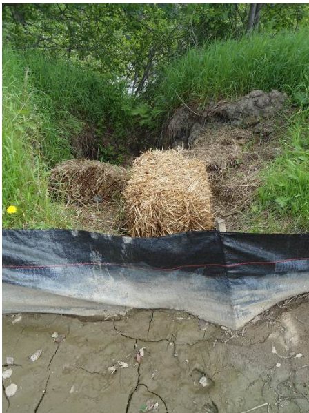
Barrières à sédiments et ballots de paille
