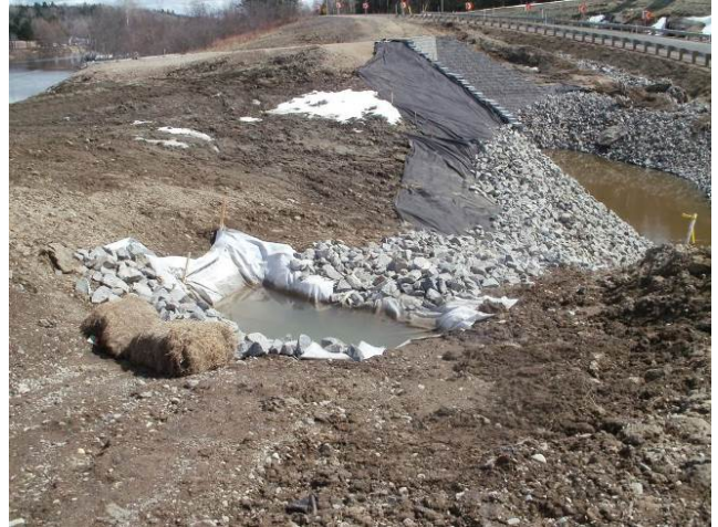
Bassin de sédimentation et ballots de paille
