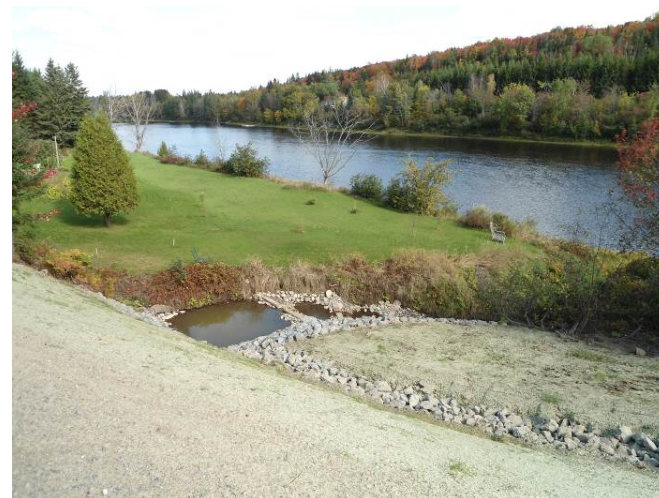
Seuils aménagés permettant la circulation du poisson (Plantations pas encore présentes)
