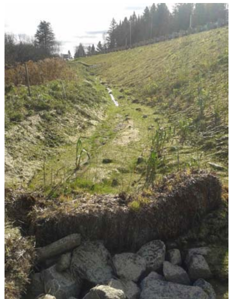
Berge filtrante couplée à un bassin de sédimentation, ballots de pailles et ensemencement (2 mois après les travaux)
