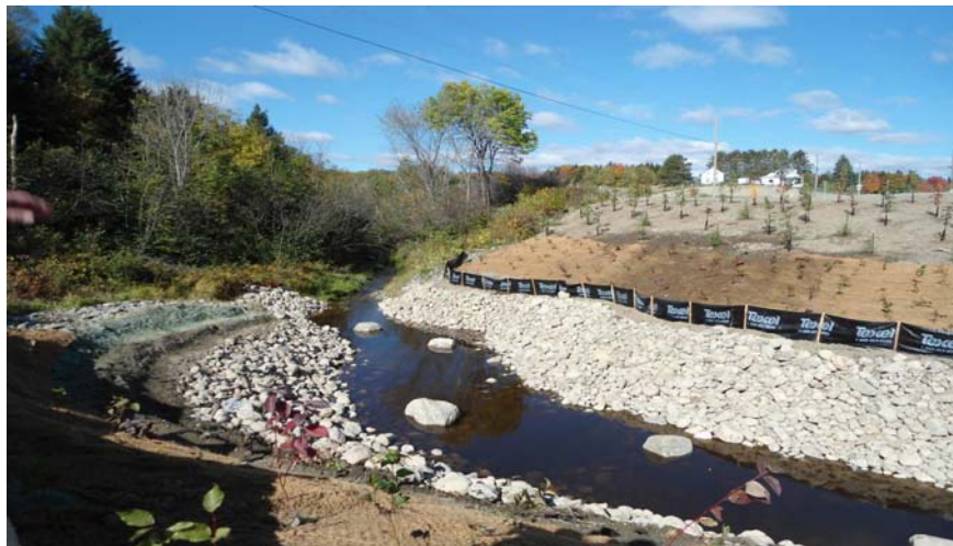
Aménagements en amont : profil sinueux, fosses, abris, végétalisation et substrat favorable pour le poisson
