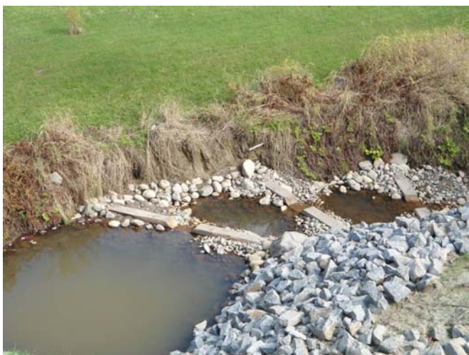
Seuils aménagés permettant la circulation du poisson (Plantations pas encore présentes)
