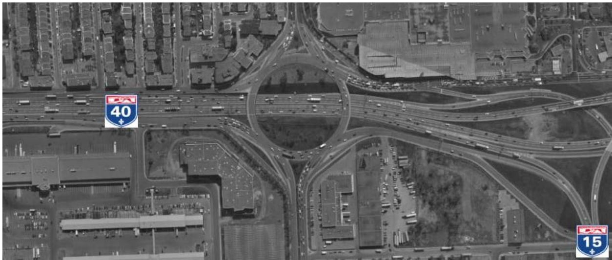
Figure 1 : Vue aérienne du rond-point avant les travaux
