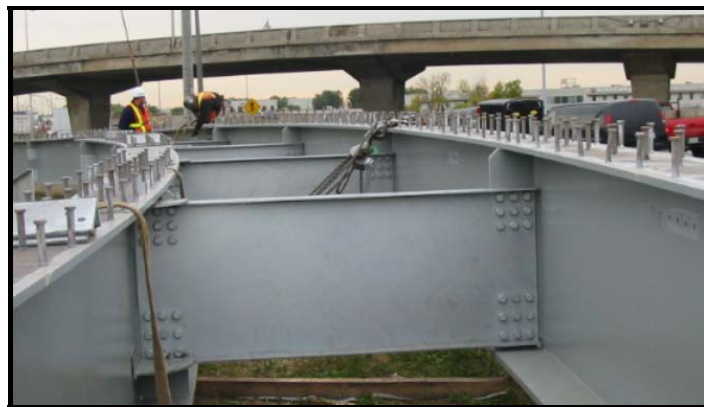
Figure 12 : Détails d'assemblage des entretoises
