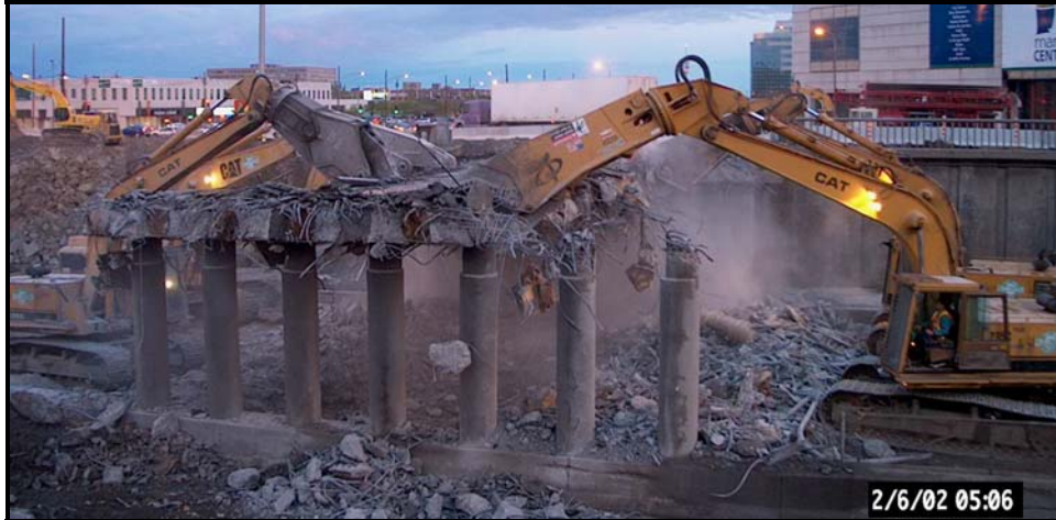
Figure 14 : Démolition du pont Est
