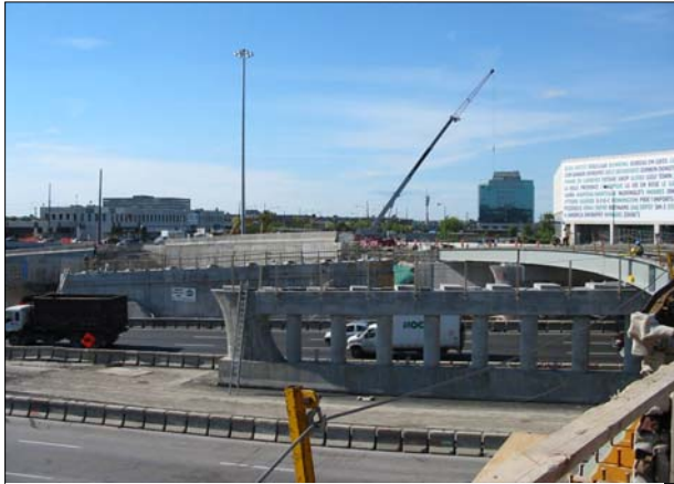
Figure 16 : Culée et pile centrale lors de l'érection de la charpente
