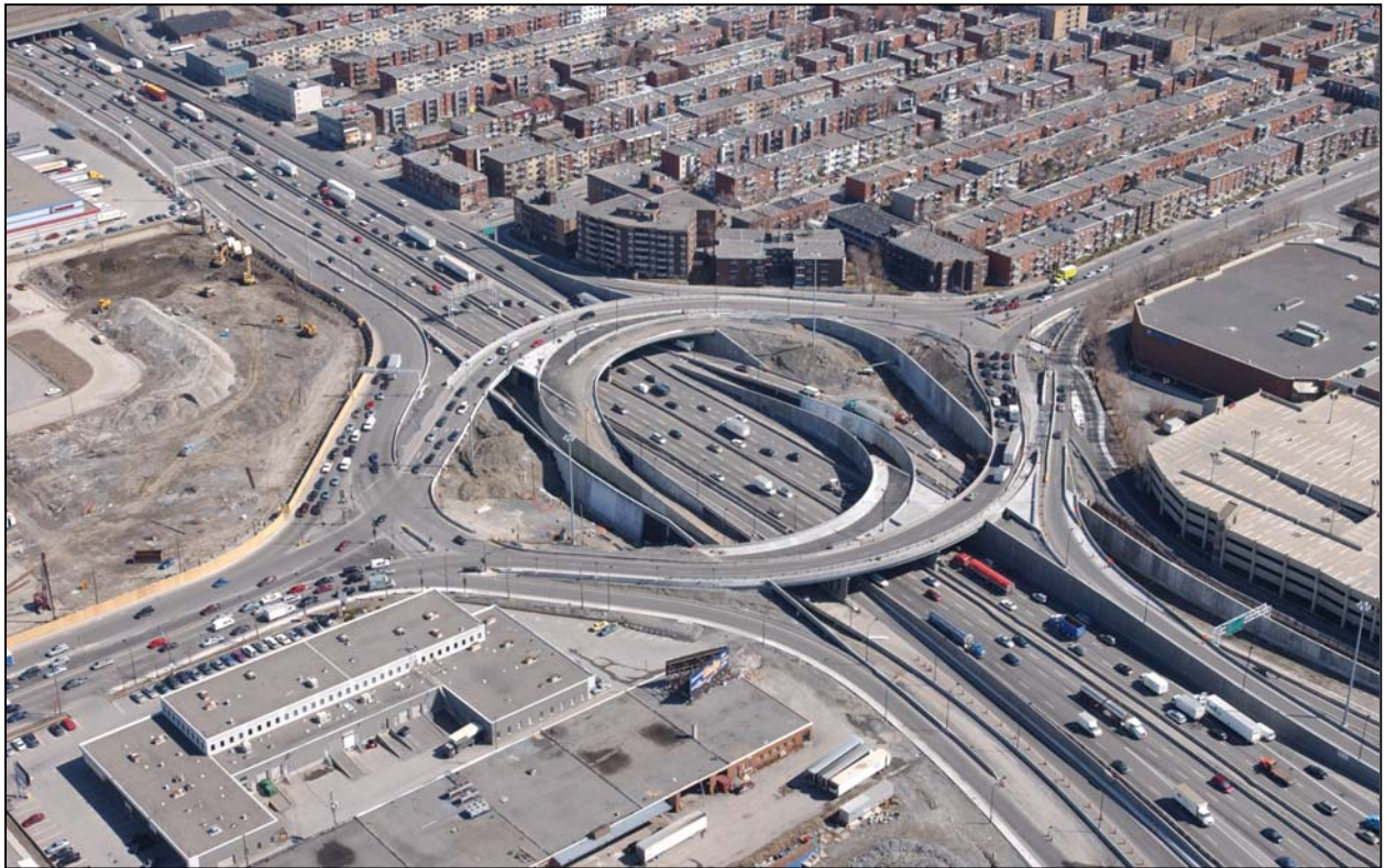
Figure 17 : Vue aérienne du chantier en mars 2004
