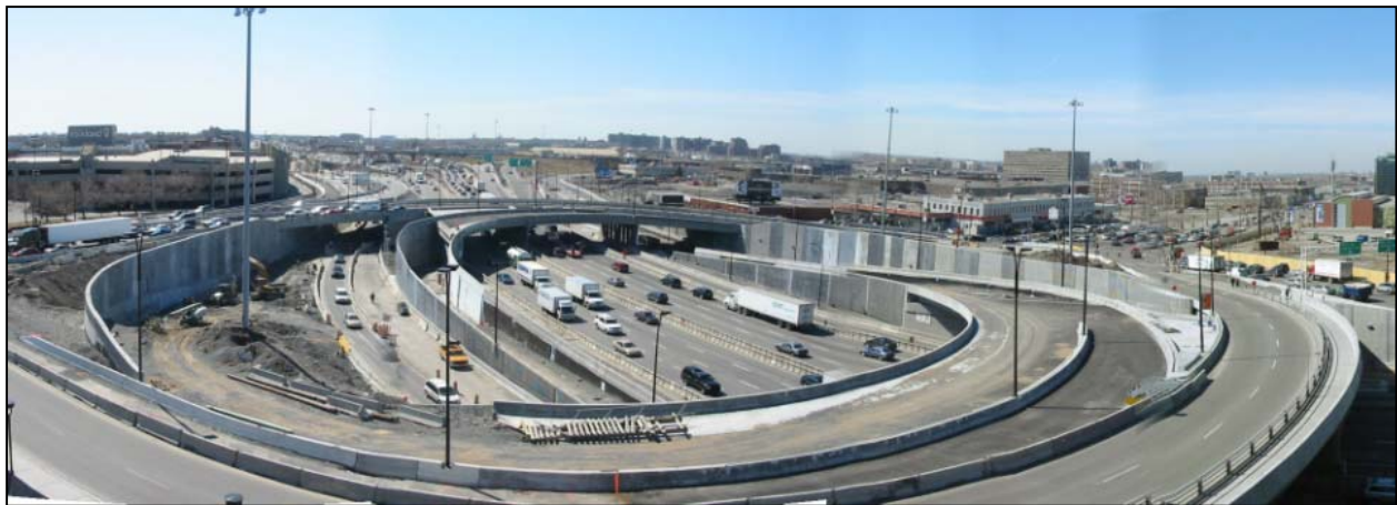
Figure 5 : État du chantier en mars 2004
