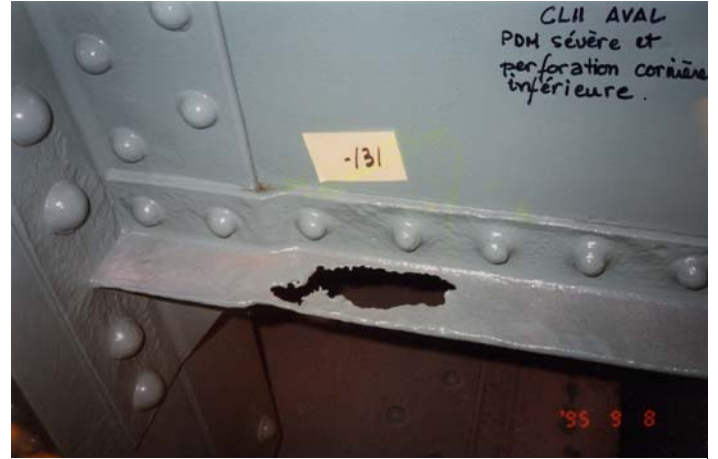
Figure 4B – Perte d'acier importante à l'endroit d'une console.
