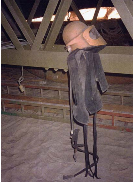
Figure 6 – Cagoule à adduction d'air pour travaux de nettoyage
