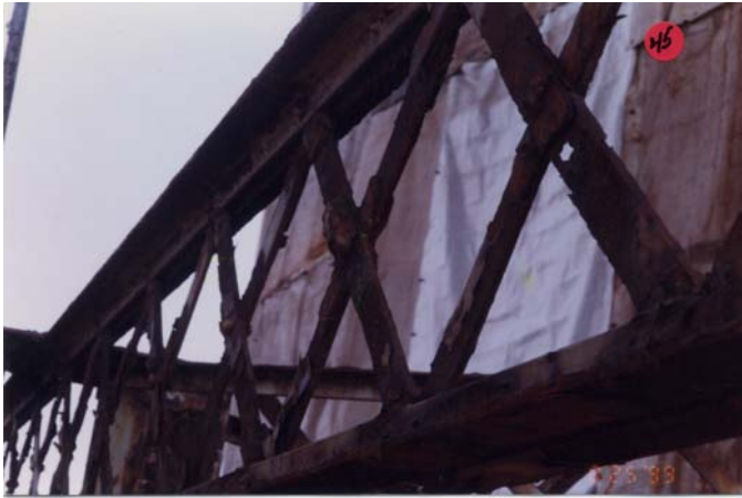
Figure 4A – Écailles de rouille sur des éléments de contreventements
