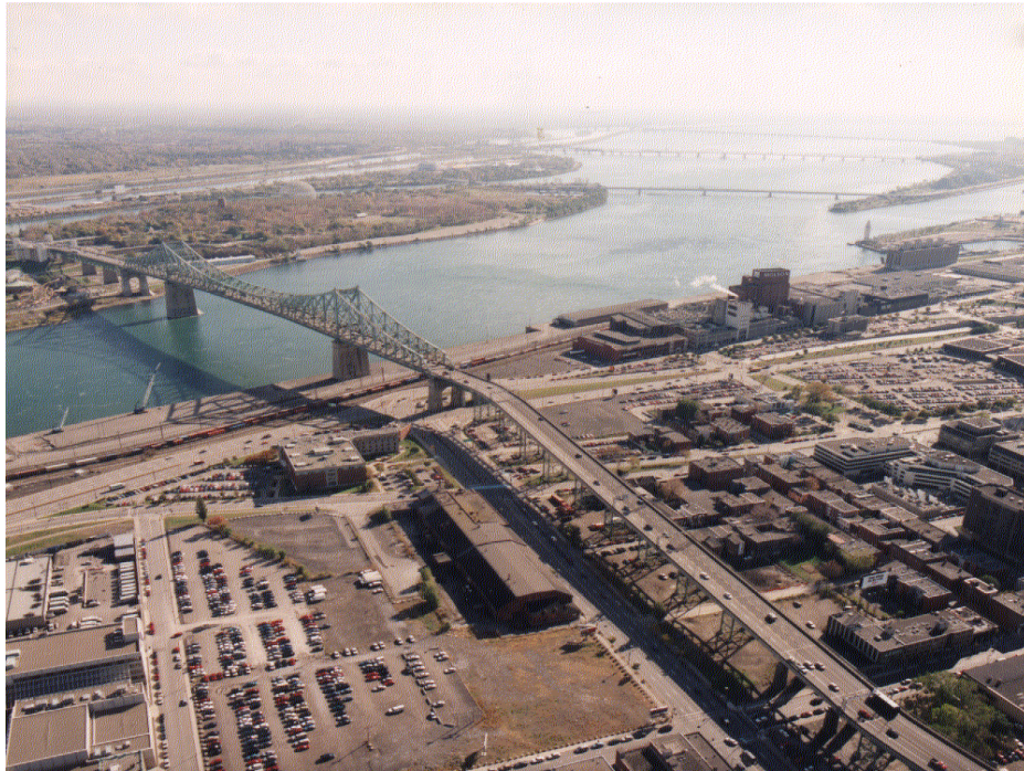
Figure 2 – Vue générale du pont incluant la travée principale
