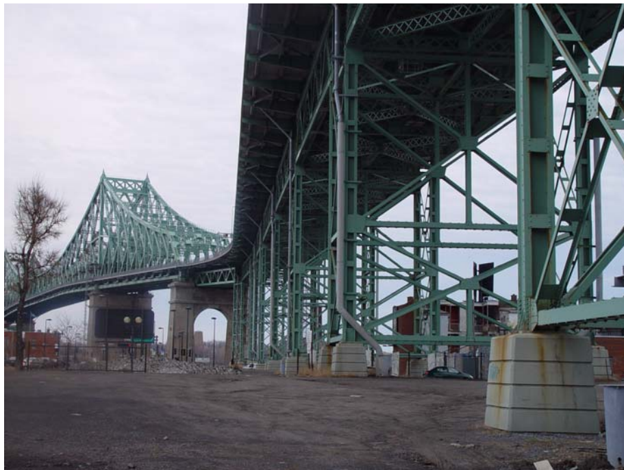
Figure 3 - Vue d'une tour en acier située à l'approche nord
