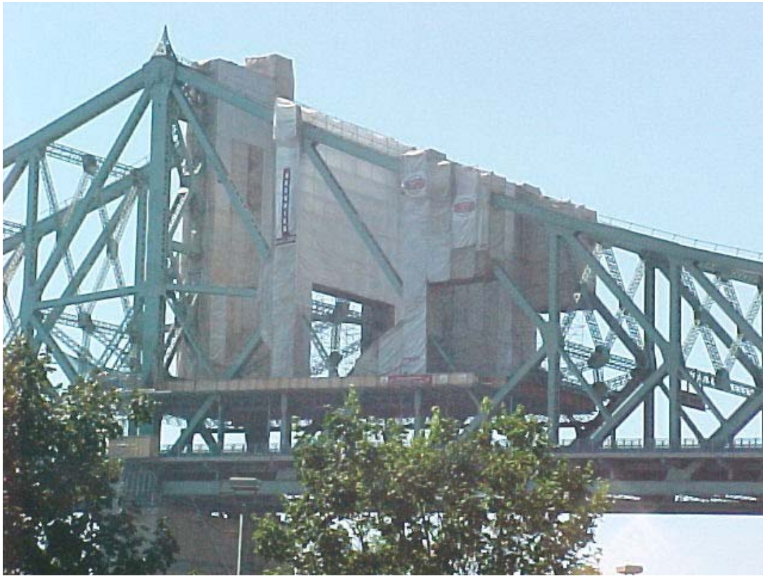
Figure 7 – Enceintes installées en 2003 pour des travaux de nettoyage et de peinture à l'endroit de la travée principale
