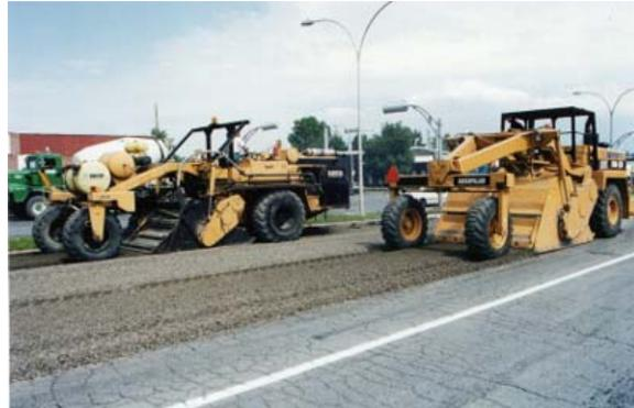
**Figure 1b : Retraitement en place (RP)**
