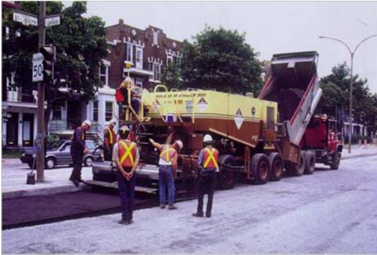
**Figure 1-a : Recyclage à froid des enrobés (RFE)**
