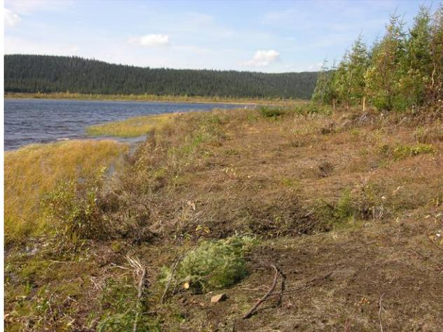
Figure 13 : Débroussaillage de la zone à inonder
