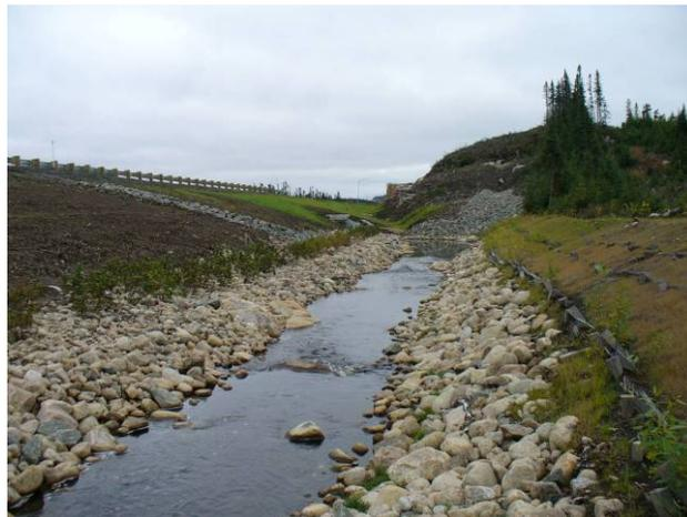
Figure 9. Aménagement du littoral et des berges du ruisseau des Brûlés au km 125 du projet de réaménagement de la route 175 (photo : Martin Lafrance).
