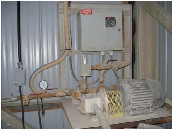
**Figure 2 – HyperTherm Dosing Pump**
