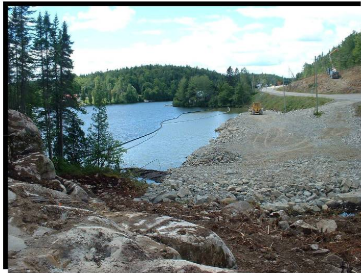
FIGURE 138 Utilisation d'un rideau de confinement retenu au fond de l'eau au droit de travaux de remblai dans le lac Bouchard, doublé du côté des travaux d'une estacade flottante de rouleaux absorbants. Longueur de 180 m et profondeur d'eau variant de 0 à 3,5 m. Route 172 à Sainte-Rose-du-Nord. (2005.1181)
