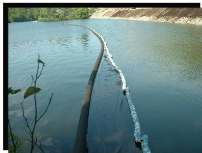
FIGURE 139 Utilisation d'un rideau de confinement retenu au fond de l'eau au droit de travaux de remblai dans le lac Bouchard. Membrane cousue sur un tuyau flottant en surface et attachée à une chaîne étalée sur le lit du cours d'eau. Route 172 à Sainte-Rose-du-Nord. (2005.1182)
