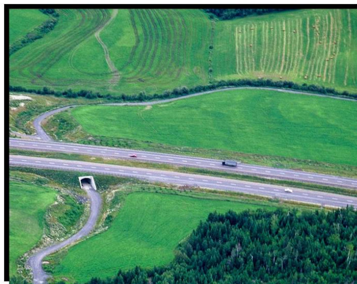
FIGURE 20 Autoroute 70 à Jonquière, secteur du rang Saint-Benoît. (2003.1074) Structure pour la traversée de la machinerie agricole et chemins d'accès. (Voir commentaires de la figure précédente)
