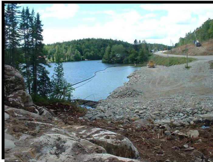
**FIGURE 138** Utilisation d'un rideau de confinement retenu au fond de l'eau au droit de travaux de remblai dans le lac Bouchard, doublé du côté des travaux d'une estacade flottante de rouleaux absorbants. Longueur de 180 m et profondeur d'eau variant de 0 à 3,5 m. Route 172 à Sainte-Rose-du-Nord. (2005.1181)
