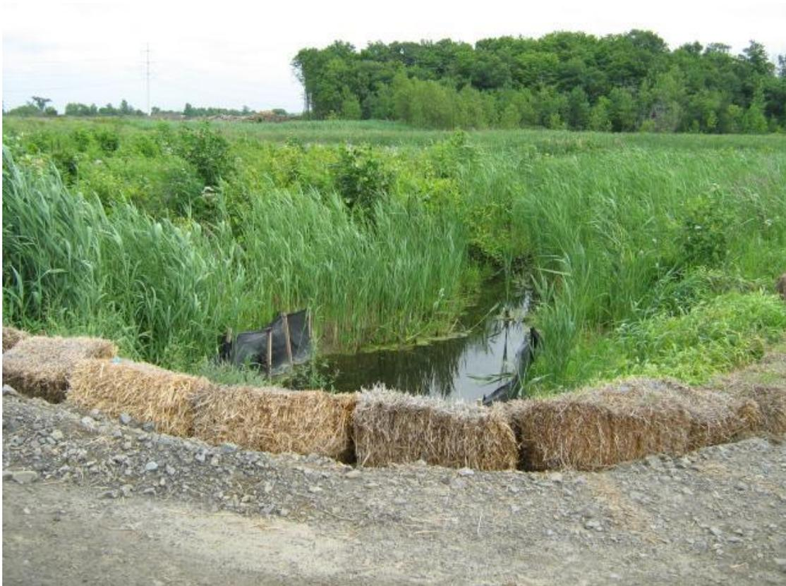
Figure 10 : mesures de contrôle des sédiments le long d'un milieu humide à Laval
