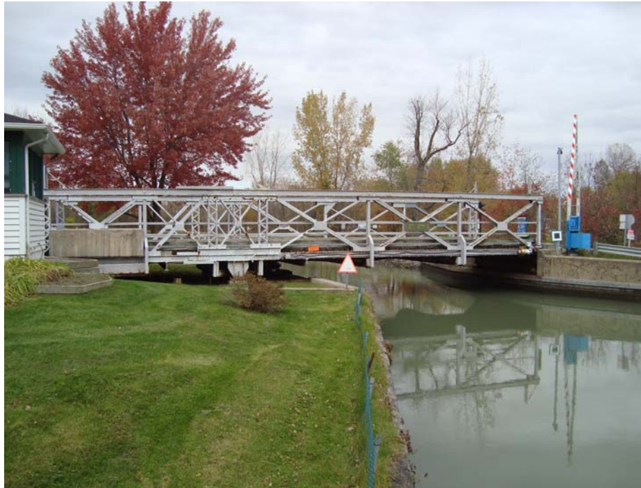
Figure 6 – Vue d'ensemble du Pont 9 existant sur le canal de Chambly
