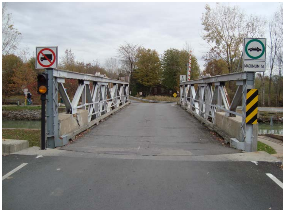
Figure 7 – Vue de la voie carrossable du Pont 9 existant
