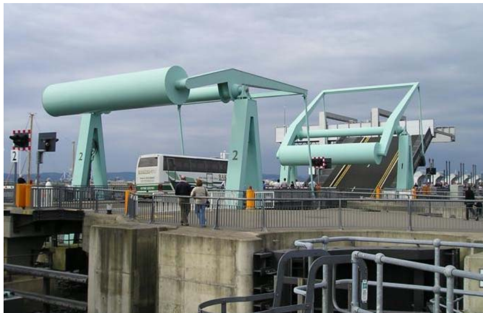
Figure 9 – Type de pont retenu pour le pont 9 du canal de Chambly [réf. : Ponts à bascule des écluses de Cardiff]
