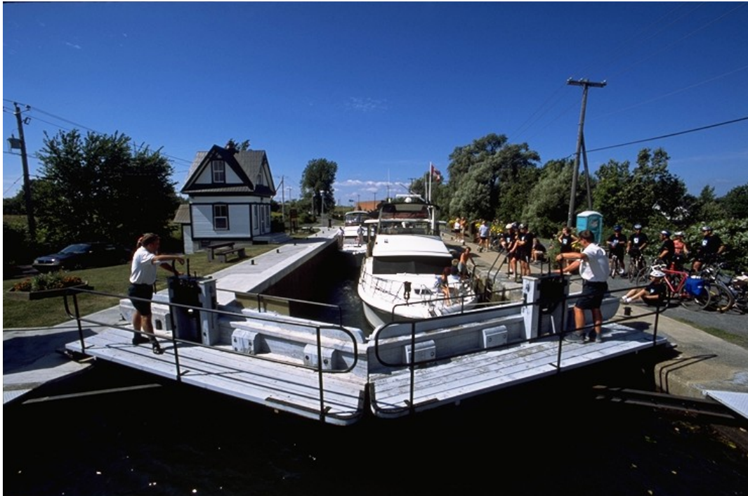
Figure 2 – Vue d'une des nombreuses écluses en opération du canal
