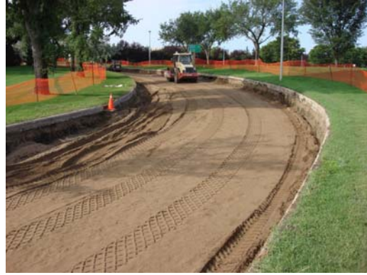
b) Sand subbase layer
