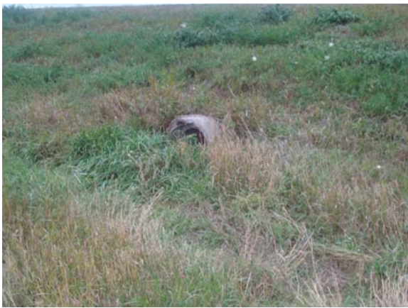
a) Culvert end (km 11.970)
