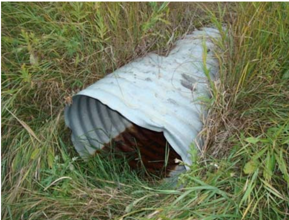
a) Culvert end (km 1.400)
