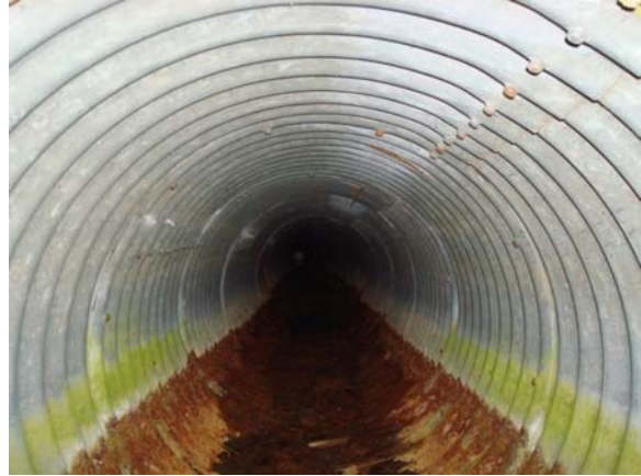
b) Culvert interior (km 11.970)
