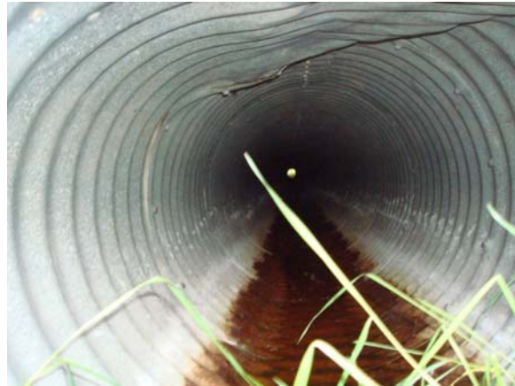
b) Culvert interior (km 1.400)
