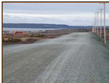
Figure 3 : Tassements localisés sur toute la largeur de la route d'accès d'Umiujaq
