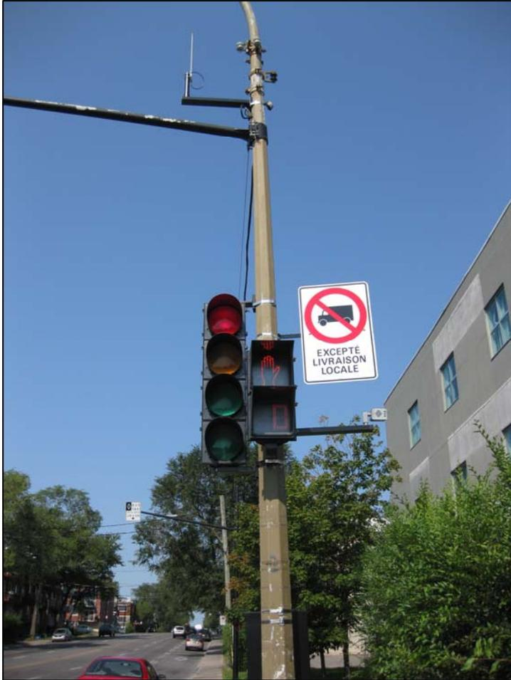
**Figure 8 : Installation des antennes sur les fûts de la Ville de Montréal**
